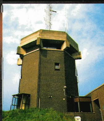
Hydro Meteo Centrum Rijnmond
