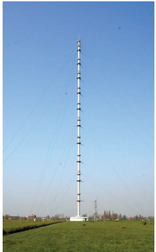
De 200 meter hoge meetmast van het KNMI in Cabauw vlakbij Lopik
