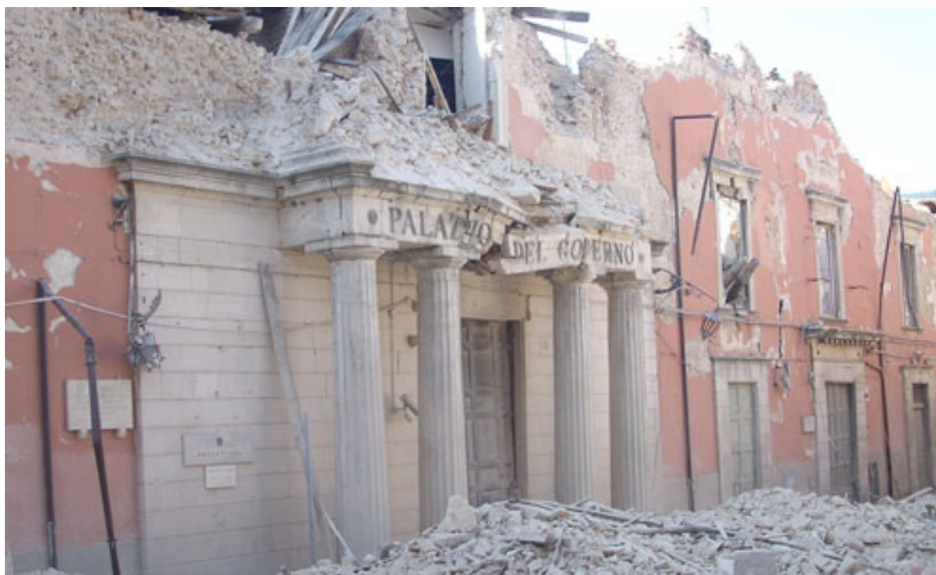
Ravage door de aardbeving in L'Aquila, Italië, april 2009.
