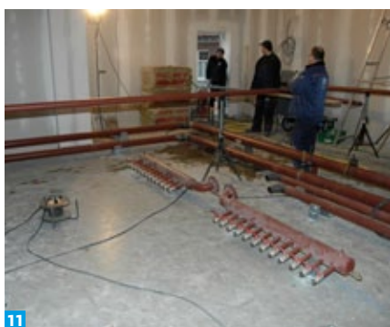
9. Dieselgenerator arriveert, die als noodstroomvoorziening gaat fungeren. | 10. Buizensysteem van warmte-koude-opslag op het dak. | 11. Buizensysteem van warmte-koude-opslag binnen. | 12. De laatste tegel wordt gelegd.
