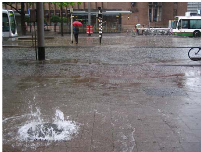
Overstromend riool, Coolsingel Rotterdam. Foto: Hilde Ongerling.
