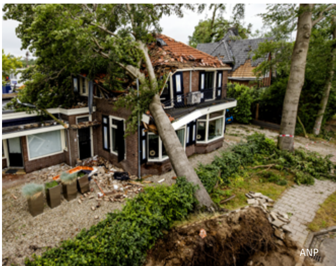
Door een valwind raakten enkele huizen in Leersum zwaar beschadigd
