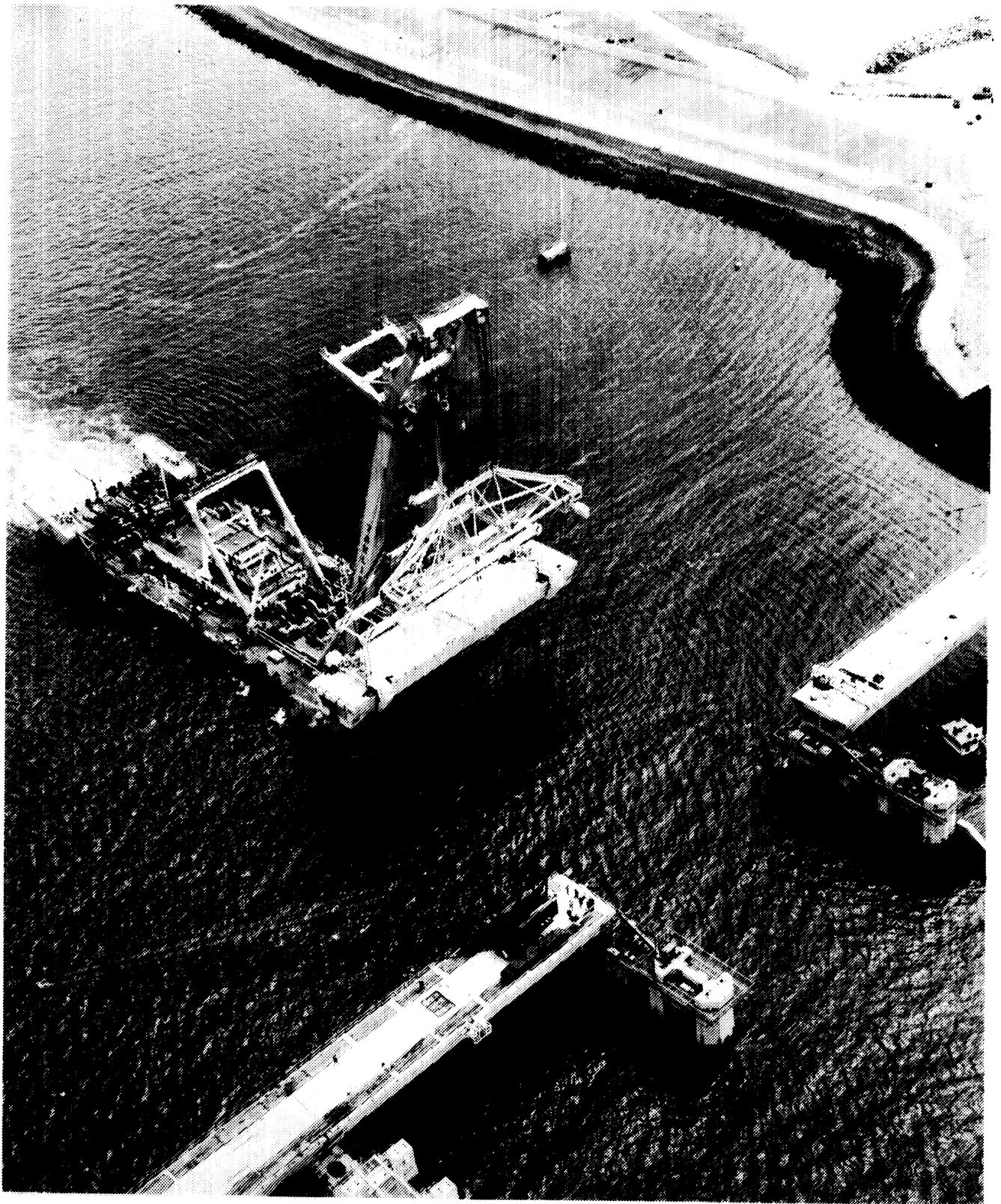
fig. 2. Het inhakken van verkeerskokers Stormvloedkering
