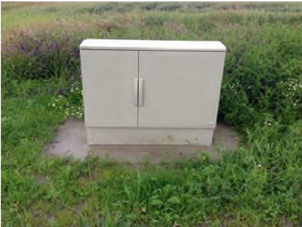
Figuur 2: Voorbeeld van een betonplaat met een meetkast
