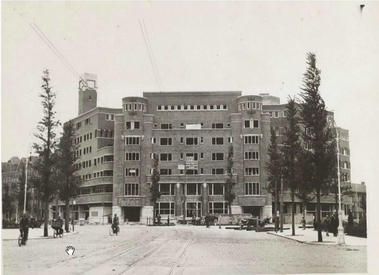
Het Nieuwe Huis in aanbouw, augustus 1927; beeldbank Archief Amsterdam
