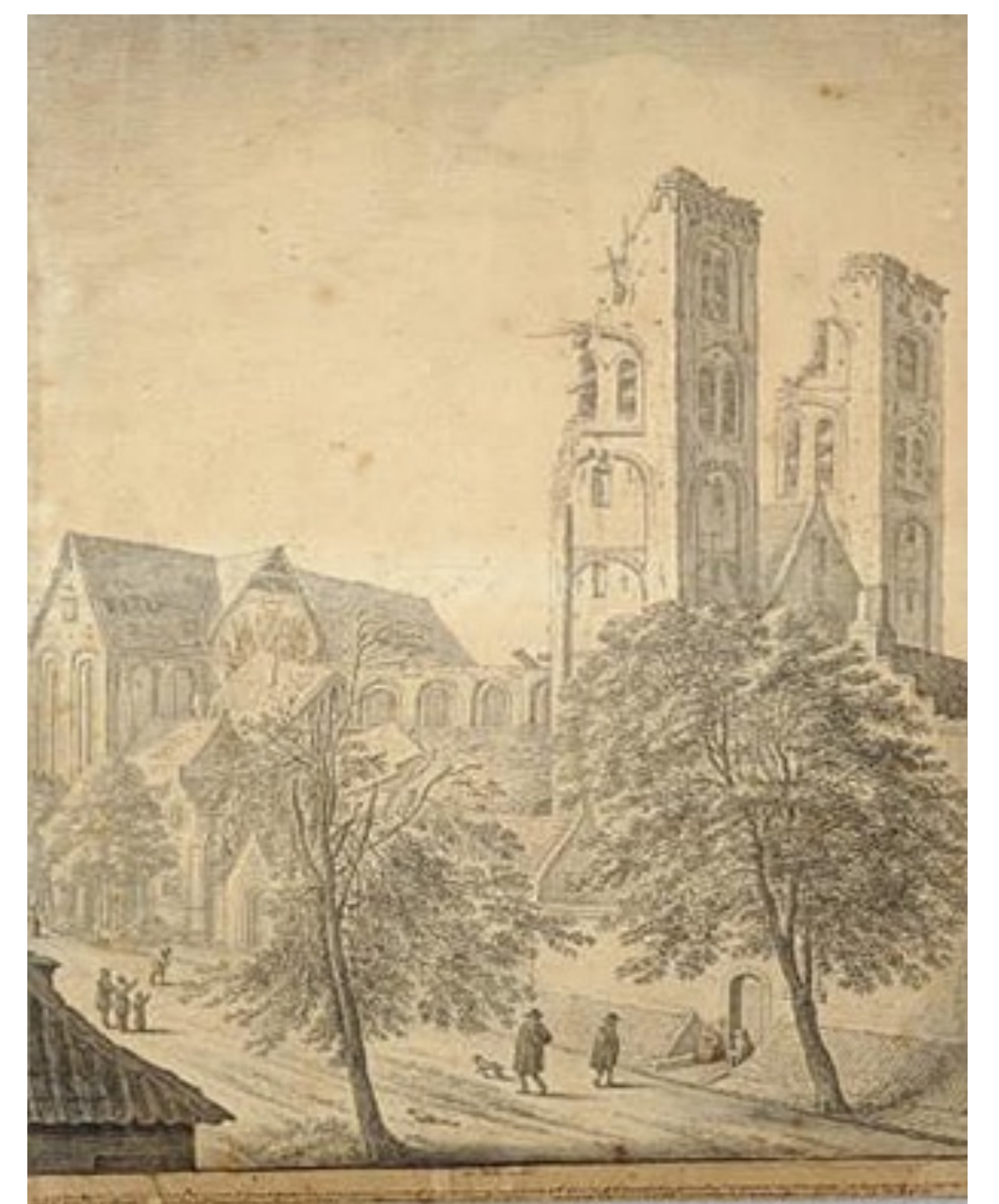
De Pieterskerk na de storm: gedeelten van de kerktorens zijn ingestort in de richting van het kerkschip (oost-noord-oost richting).
